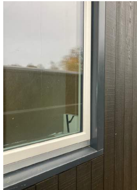
Het kozijn ligt vlak in de gevel.
