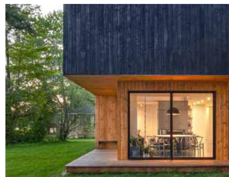
Grote uitkragingen zijn goed te realiseren in houtbouw.
