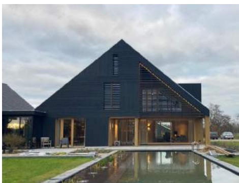
Bij de schuurwoning is de constructie zichtbaar.
