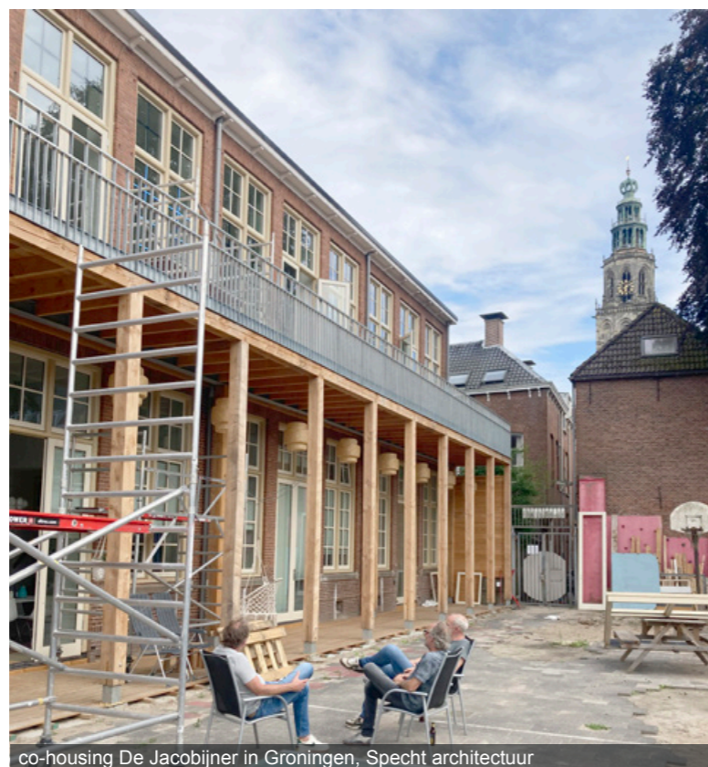
co-housing De Jacobijner in Groningen, Specht architectuur
